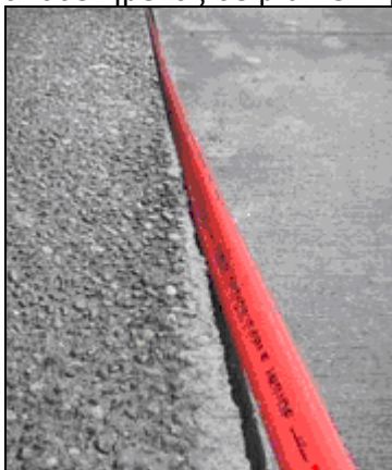
Σχ.13.: Τυπική εγκατάσταση σωλήνα για χάνδακα (micro Trencher)
